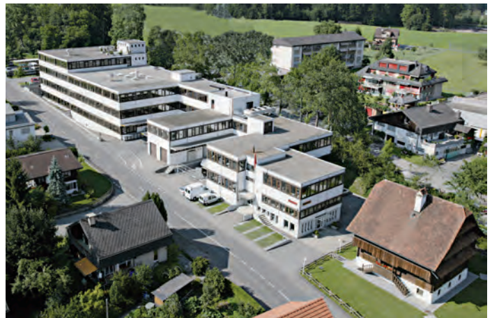
Leister Technologies AG, производственное здание, Кегисвиль, Швейцария
