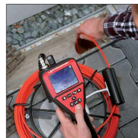
Обследование дождеприемников
