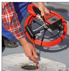
Обследование водостоков
