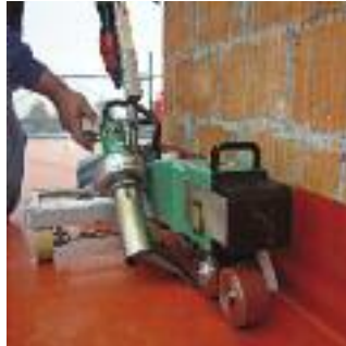
Благодаря узкой конструкции возможна сварка на расстоянии до 110мм до стены.
