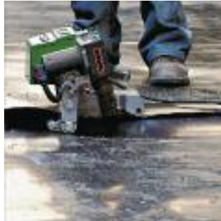
TWINNY T с комбинированным клином при сварке геомембраны из ПЭНД.
