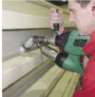
Угловая насадка 45° для WELDPLAST S2 облегчает сварку в труднодоступных местах (принадлежность).
