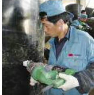
Экструдер FUSION 2 при сварке резервуара.
