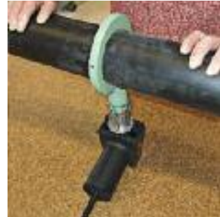
Сварка труб при помощи зеркальной насадки.
