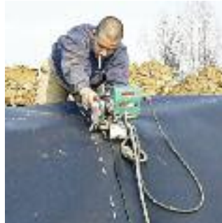
... на обустройстве полигона.
