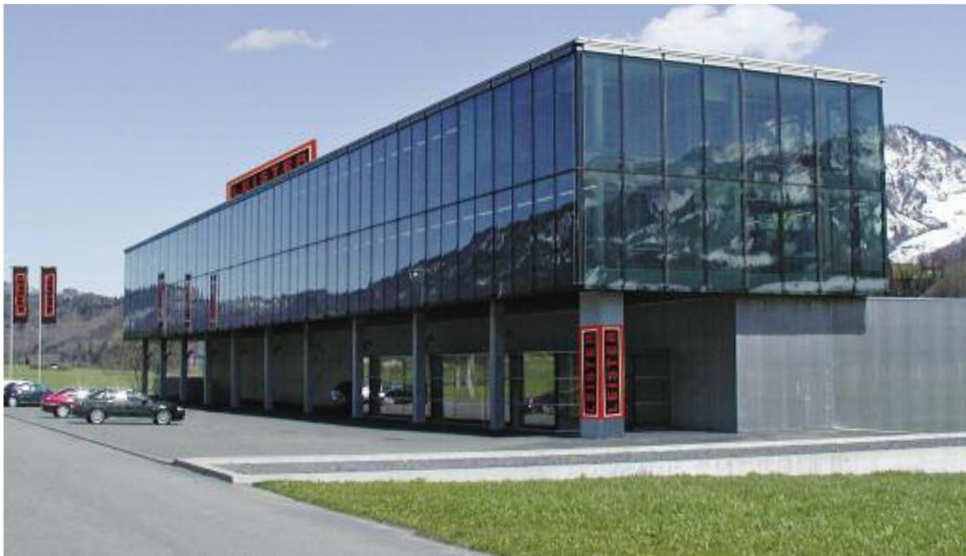
Здание корпоративного центра фирмы Leister, Кегисвиль, Швейцария
