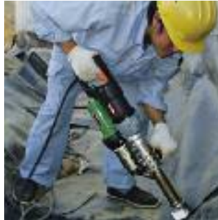
Благодаря своей длине экструдер FUSION 3 особенно подходит для использования в области подземного строительства.
