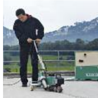
Новый VARIMAT V2 в работе. Автомат доставлен на крышу в практичном ящике.
