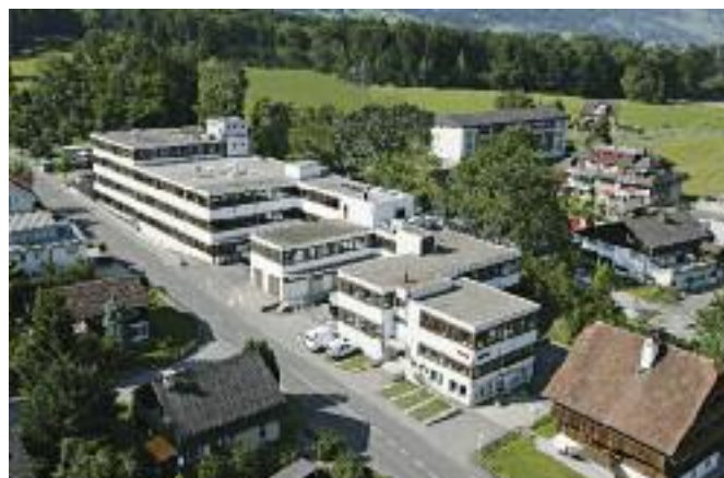
Производственные корпуса Leister Technologies AG, Кегисвиль, Швейцария
