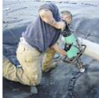
WELDPLAST S6 на монтажных работах при обустройстве полигонов.
