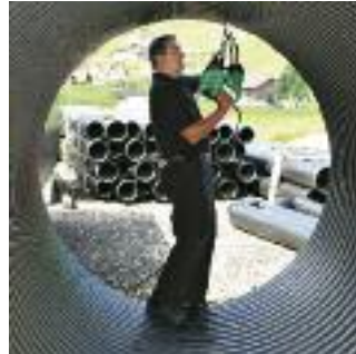
Удобный WELDPLAST S2 в работе.
