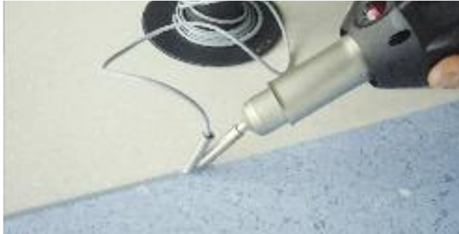
Сварка напольных покрытий из ПВХ при помощи TRIAC BT
