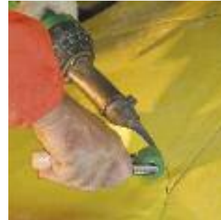
Прикаточный ролик - незаменимая принадлежность при проведении работ в тоннелях.
