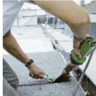
Мощный ELECTRON с широкой щелевой насадкой при сварке битумного покрытия.
