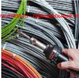
HOT JET S с решетчатой рефлекторной насадкой при установке термоусадочной муфты.
