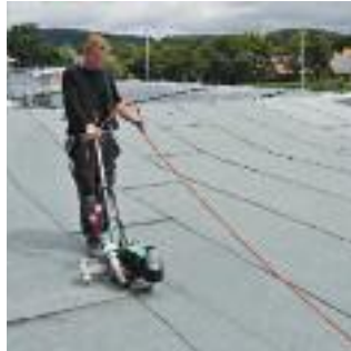
Простое направление автомата и чистая сварка при использовании BITUMAT B2.
