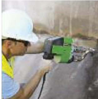
Мощный WELDPLAST S4 в работе.
