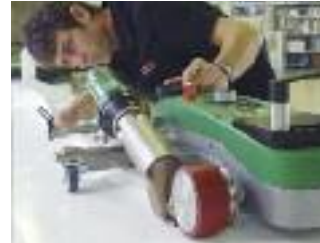
Простая сварка с подворотом и кедером при использовании спец. комплекта.
