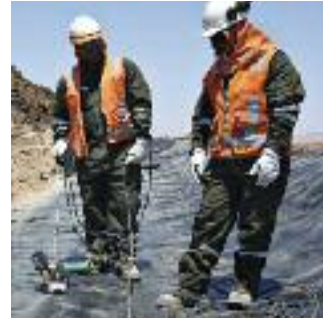
TWINNY S с комбинированным клином при сварке на одном из южноамериканских рудников.
