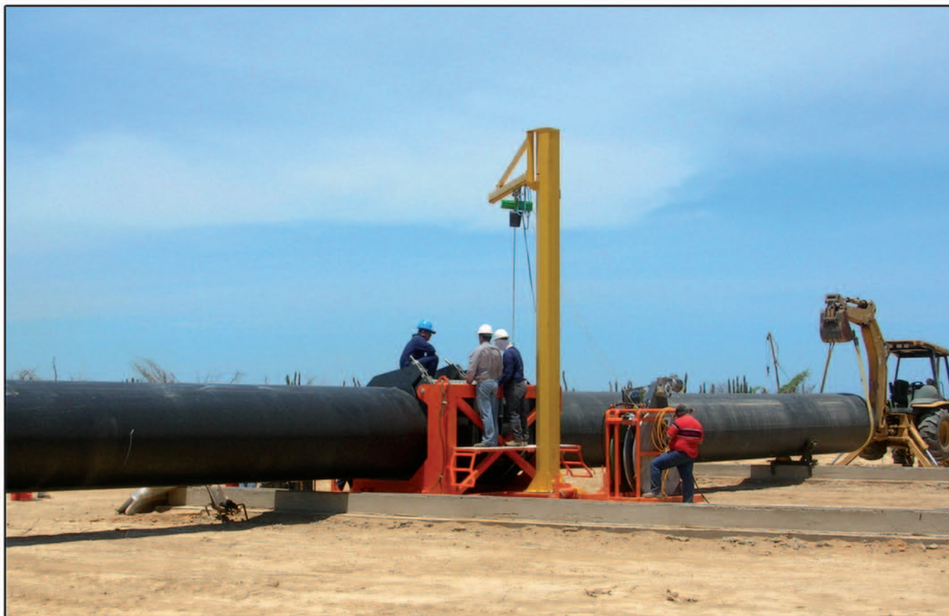
Тележка центратора и электрический кран (опция)
