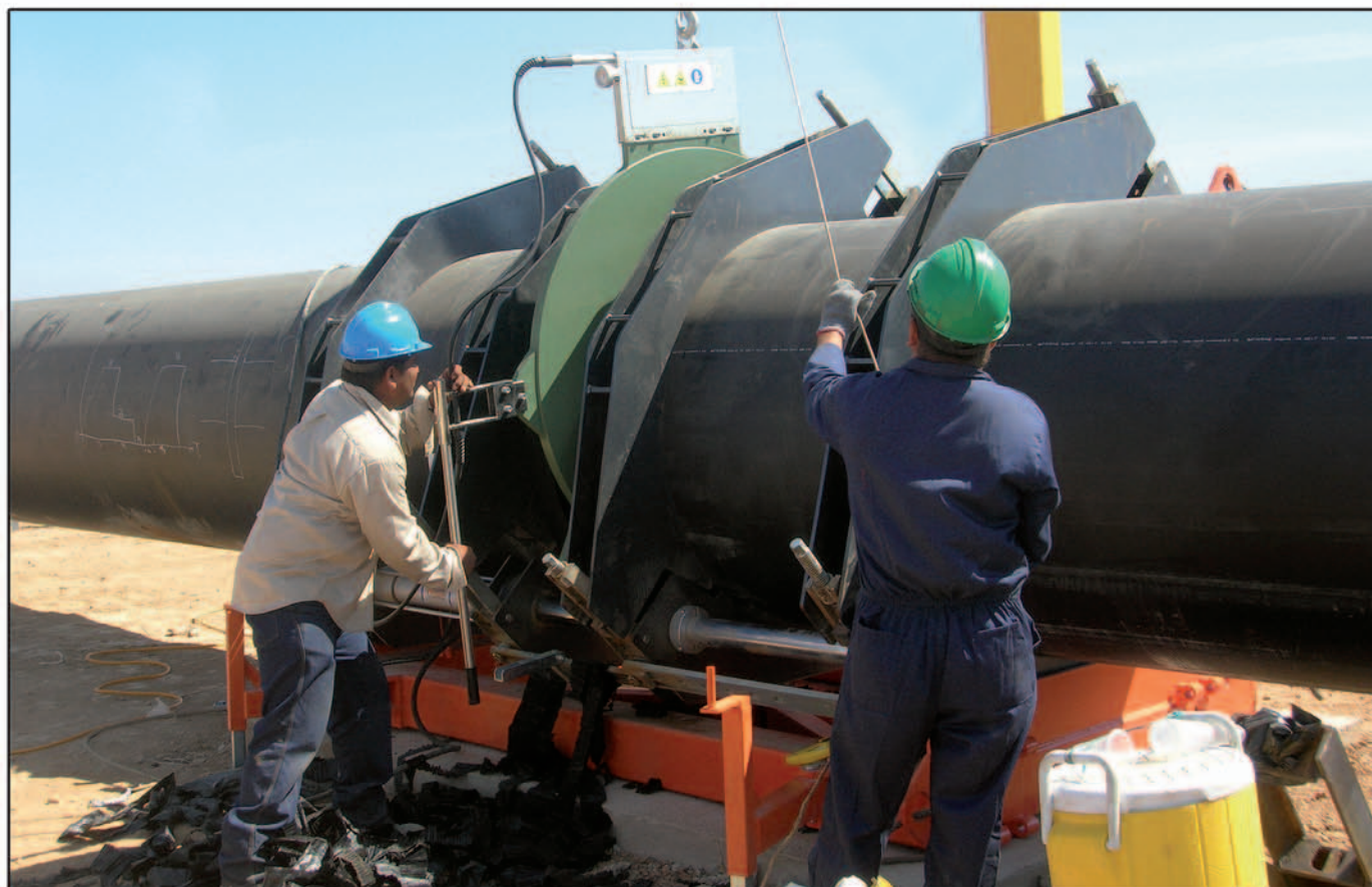
Тележка центратора и электрический кран (опция)
