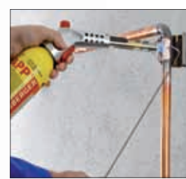
Пайка мягким припоем при монтаже системы отопления
